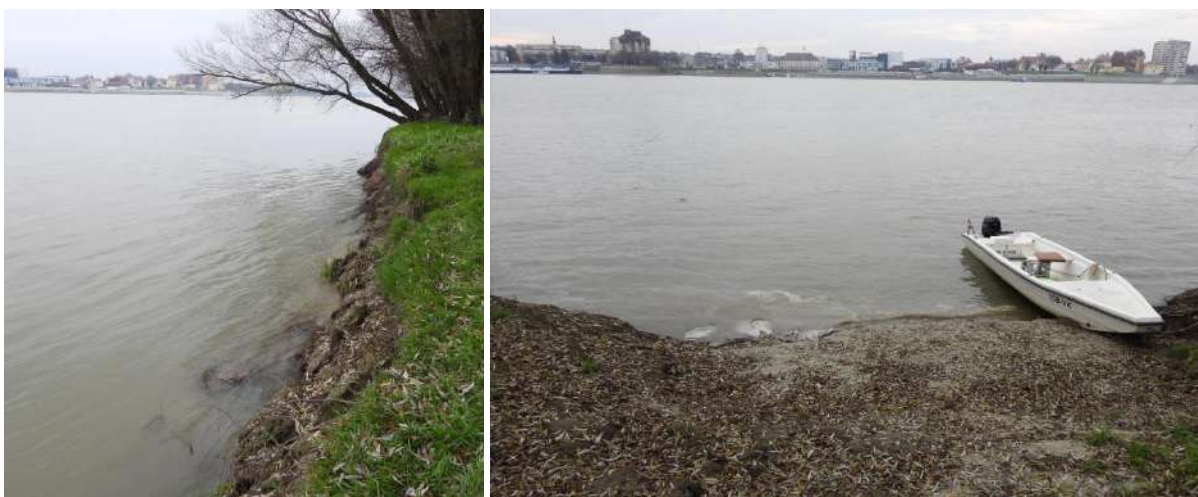
Fotografije C-7: Erodirana desna obala ade (lijevo), plaža na kojoj pristaju plovila koja dolaze na adu (desno)
