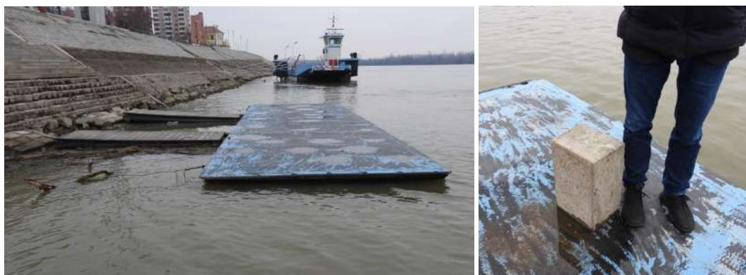
Fotografije E-1: Ponton na obali Dunava na koji pristaje brodice koja prevozi putnike na vukovarsku Malu adu; izgled sidrišta
